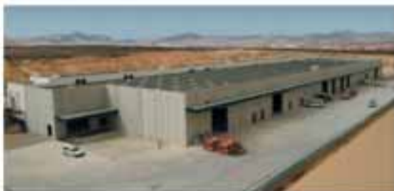
Vista general del edificio de almacenes y talleres, con una superficie útil total de 9.150 m 2
